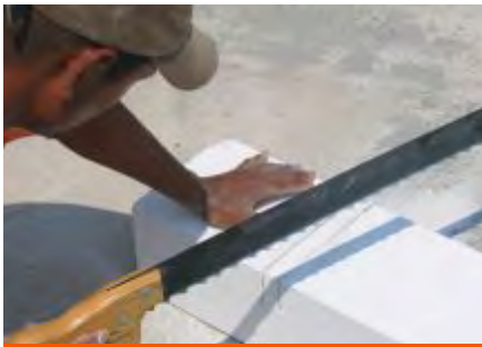
Fig. 16A: Corte con serrucho.
