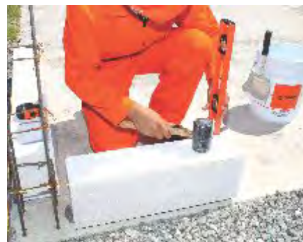
Fig. 7: Nivelando con mazo de goma.
