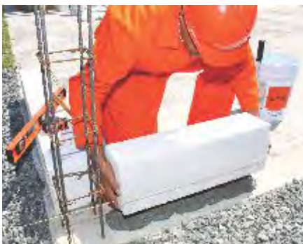
Fig. 6: Desplante de block Hebel®.
