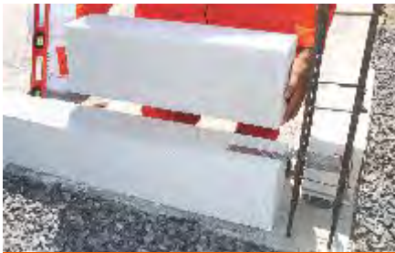
Fig. 9: Cada block se deberá de alinear y nivelar.
