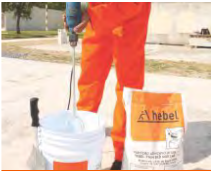
Fig. 5: Mezclado de Adhesivo Hebel®.
